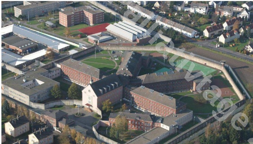
Im Zentralkrankenhaus der Justizvollzugsanstalt Kassel wird Norbert S. derzeit behandelt. Foto: JVA Kassel
